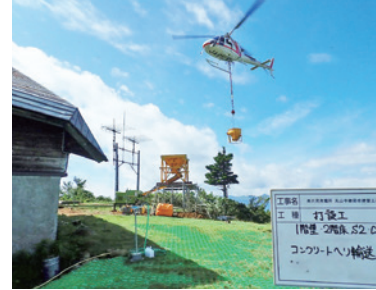
奥只見丸山 ヘリコンクリート打設
