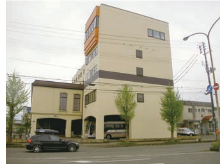
ホテル改修完了
