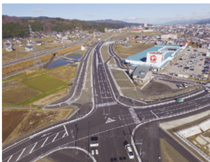
国道 17 号小栗山道路 その 10 工事
