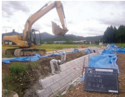
河川工事の様子
