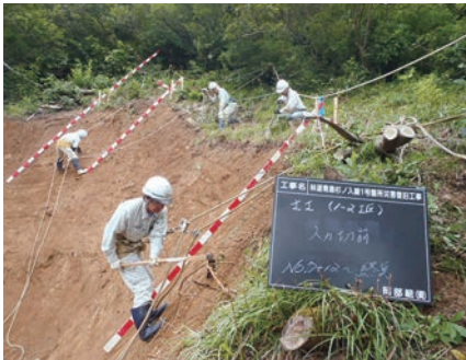
法面工事の様子
