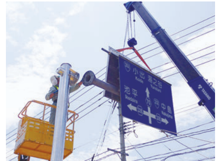
作業風景（重機使用）
