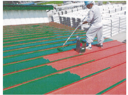
ローラーを使って屋根を塗っています
