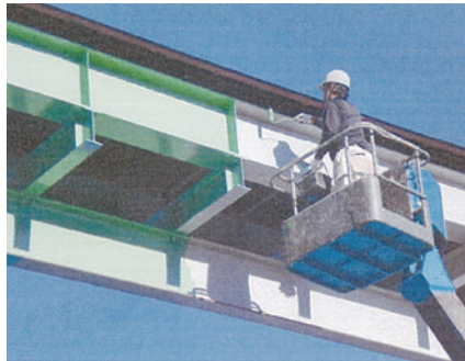
高所作業車を使って塗装
