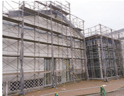
足場組立作業
