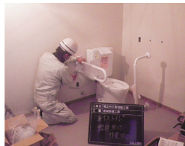
衛生器具設備工事
