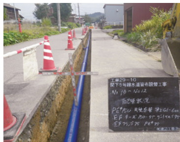
配水管布設工事
