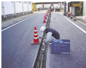
消雪パイプ布設工事
