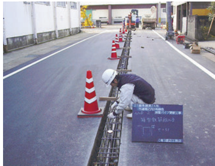
消雪パイプ布設工事
