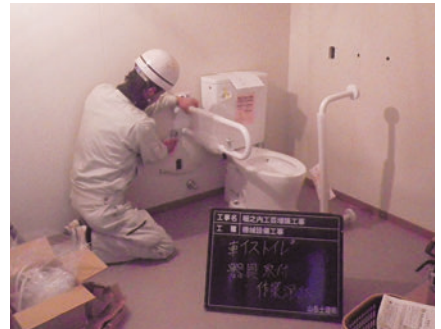
衛生器具設備工事
