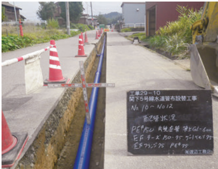
配水管布設工事
