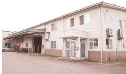
新潟工場外観
