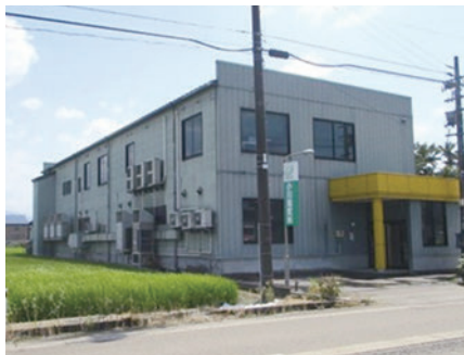
建屋外観（主工場のみ）
