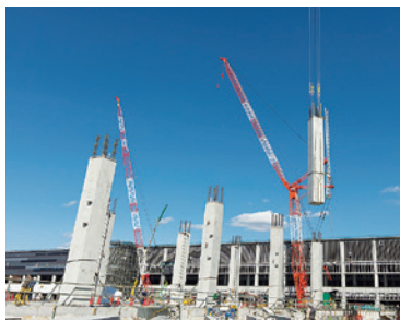
建方の様子(大手物流倉庫にて)
