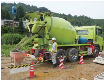
生コンクリートの運搬
