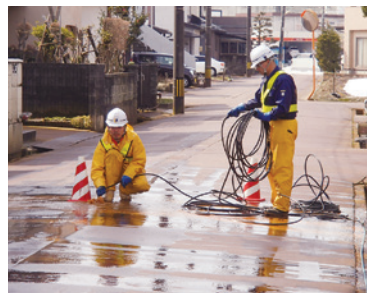
消雪パイプの洗浄
