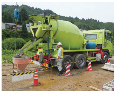
生コンクリートの運搬
