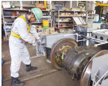
ボギー台車整備
