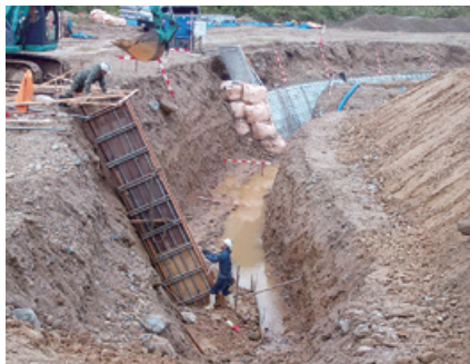
河川災害復旧工事
